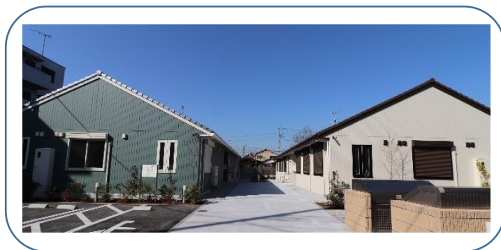
障害者グループホームかしの木 北館・南館 令和3年3月開設
